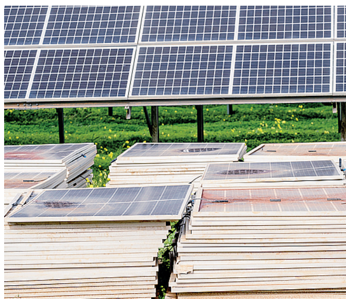
FOTOVOLTAICO La durata di vita media di un modulo è di circa 25 anni
